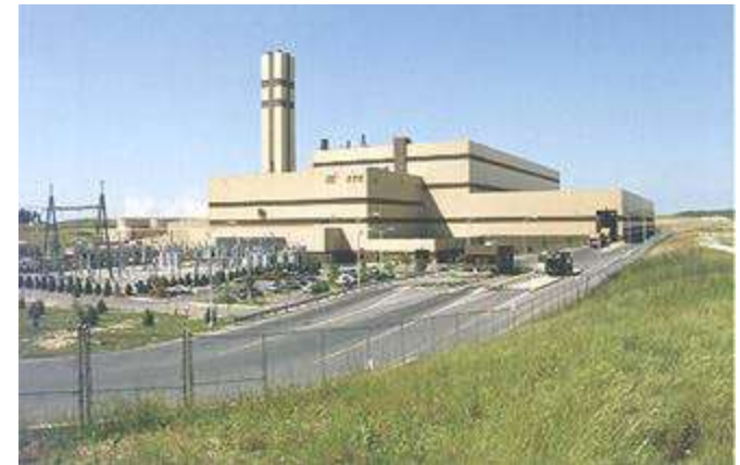
I-95 E/RRF & Landfill
