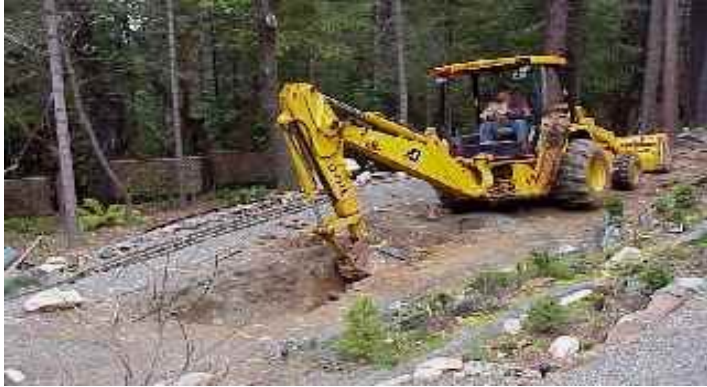
Actual Trench Excavation
