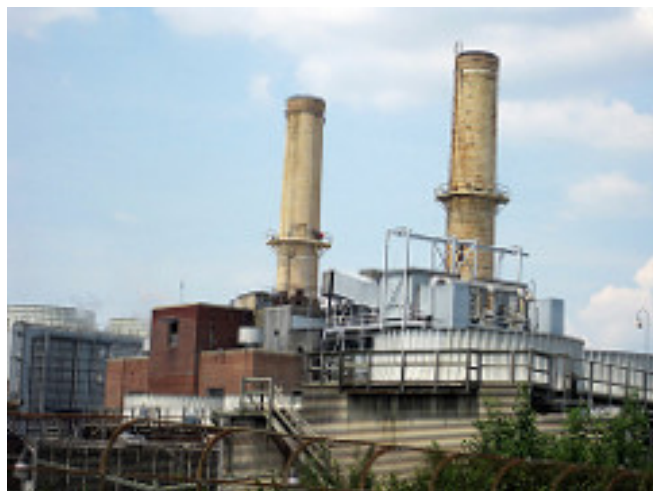
Capitol Power Plant in DC (Apasciuto, Flickr)
