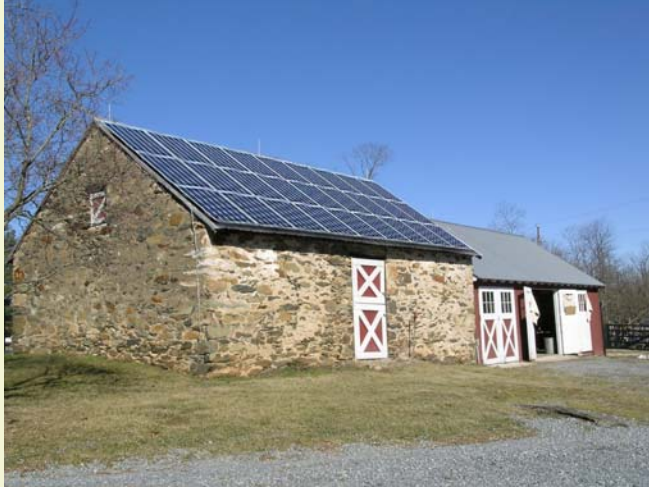
6kW PV SYSTEM UPPERVILLE, VA
