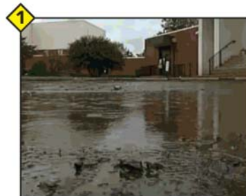
▲ Flooding on Mt. Olivet Rd NE
