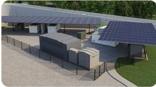
2. 2 MW / 6.88 MWh BESS
