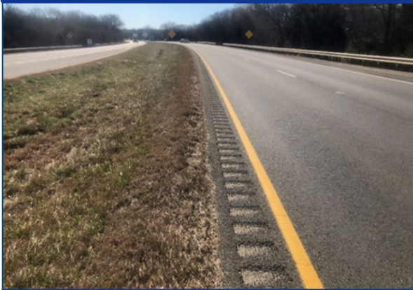
Edge line Rumble Strips
