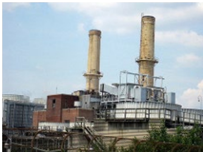
Capitol Power Plant in DC (Apasciuto, Flickr)
