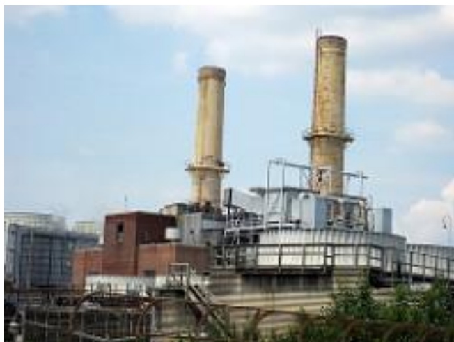
Capitol Power Plant in DC (Apasciuto, Flickr)
