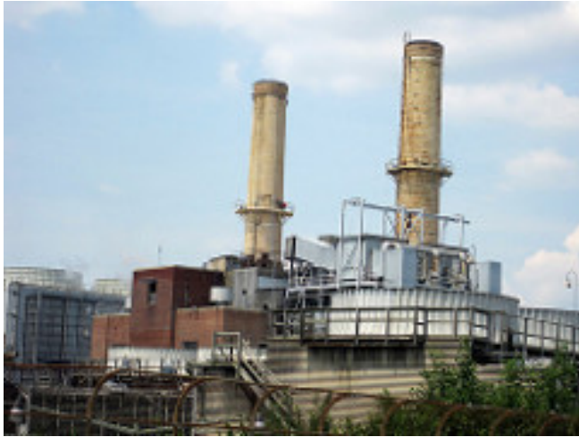
Capitol Power Plant in DC (Apasciuto, Flickr )
