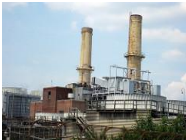
Capitol Power Plant in DC (Apasciuto, Flickr)
